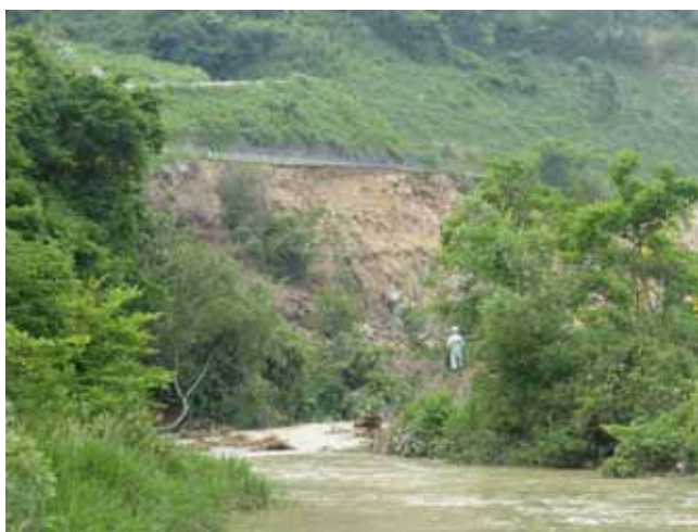
七曲地区の二迫川河崖の崩壊状況。
